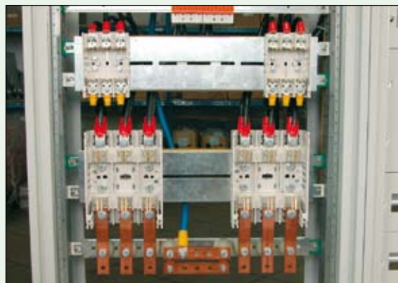
Montaż rozłączników bezpiecznikowych w rozdzielnicy szerokość 3
