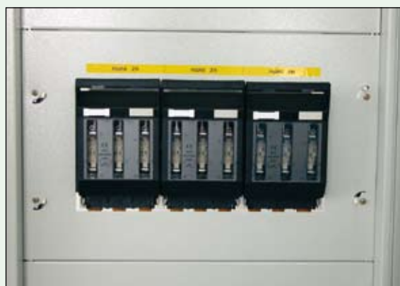
Ośłona FTR z wycięciem dla rozłączników bezpiecznikowych typu LTS
