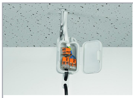
Montaż lamp wiszących w podwieszanym suficie
